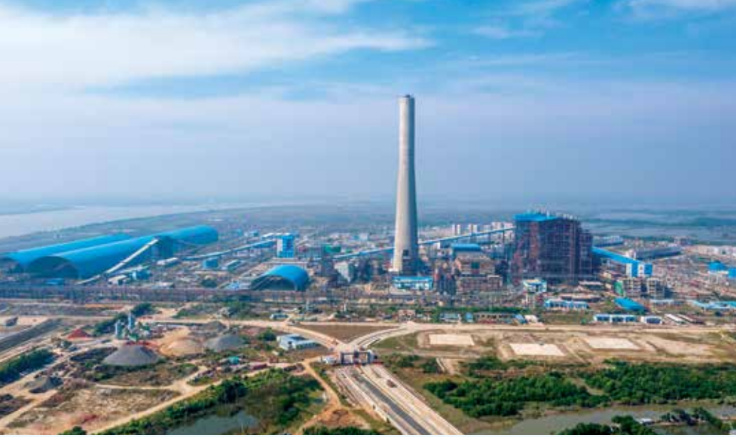
মোংলা বন্দর সচল থাকলেই সচল থাকবে রামপাল বিদ্যুৎকেন্দ্র এবং ইপিজেডগুলোর আওতাধীন শিল্পস্থাপনাসমূহের কার্যক্রম
