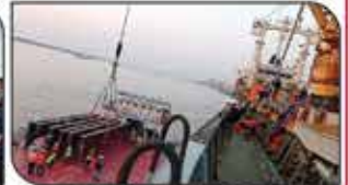
বঙ্গবন্ধু শেখ মুজিব রেলওয়ে ব্রীজ কন্সট্রাকশন প্রোজেক্ট এর মালামাল মোংলা বন্দর দিয়ে আগমন।
